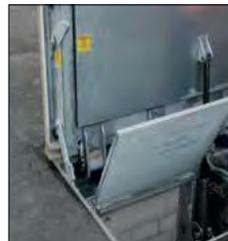
Absturzsicherung mittels Klapprost oder automatisch aufgehendes Geländer
